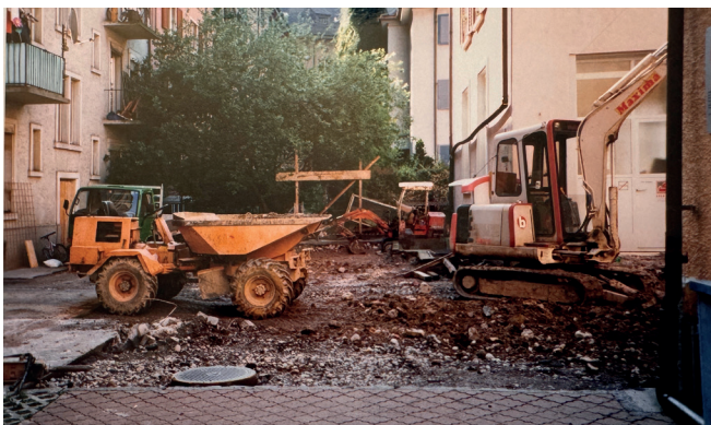
Bau Kellerverbindung Josefstrasse
